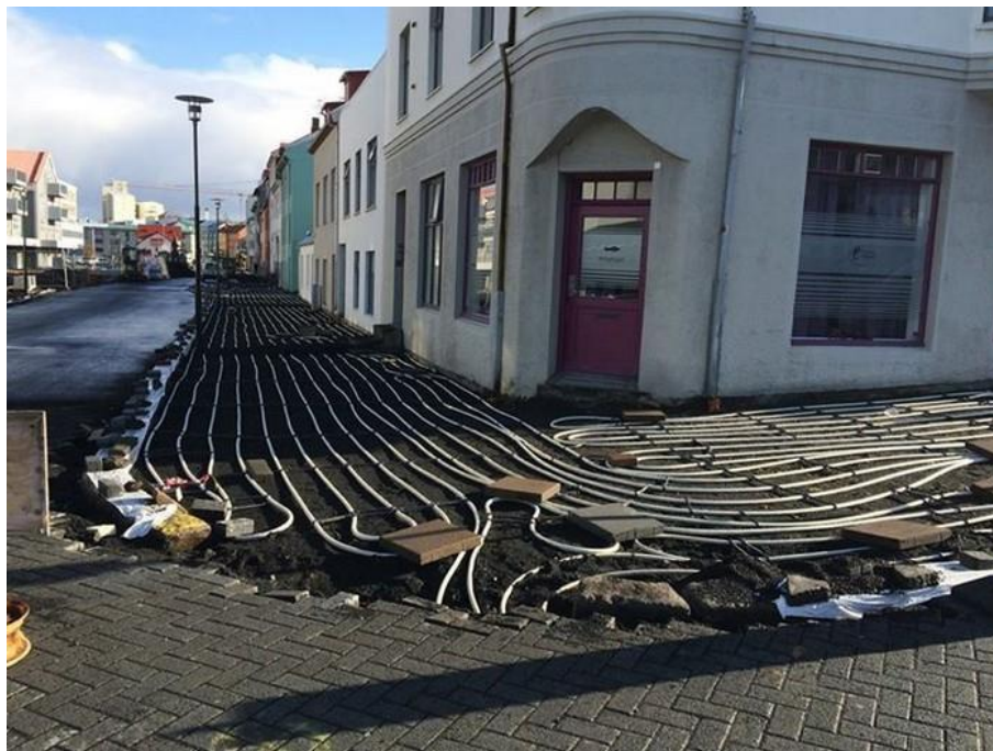
Строительство тротуара с подогревом в Рейкьявике
